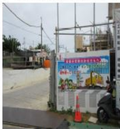
西門裏口通りの工事車両の出入り口
